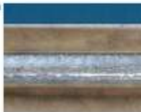
Buen cordón de soldadura sin defectos
